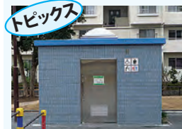
新設されたトイレ
