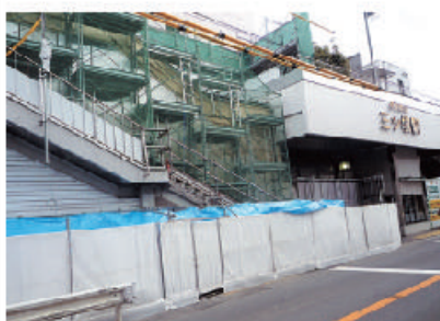
三ツ境駅エスカレーター屋根設置工事
