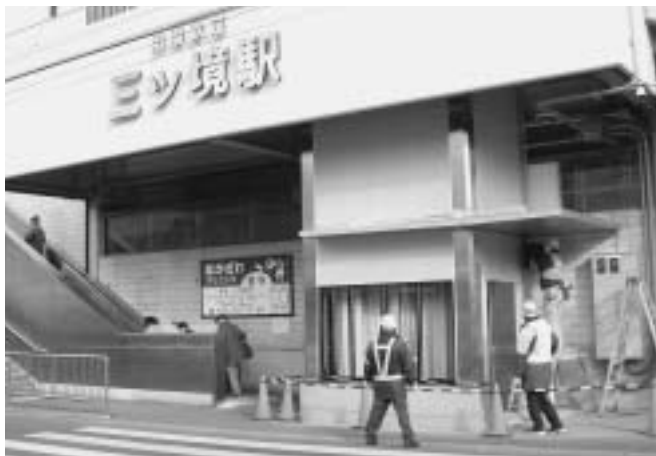
2月の稼働に向け工事が進む三ツ境駅南口エレベーター
