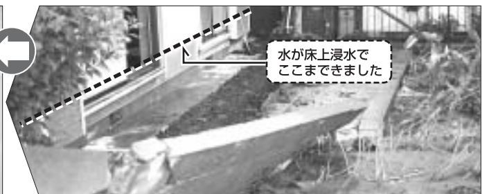
豪雨による境川の氾濫で崩壊したブロック塀 (中屋敷地区)
