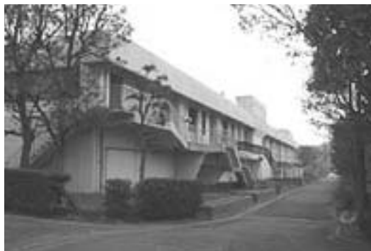
下請け作業員の死傷事故があった横浜市の西部水再生センター=戸塚区で
