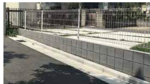
[新設フェンス]
