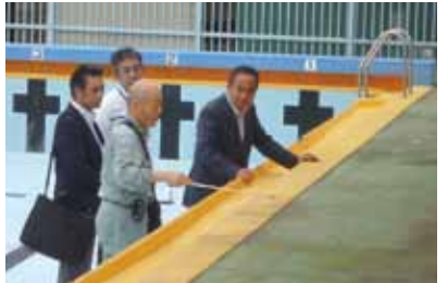
プールの劣化調査(大門小)
