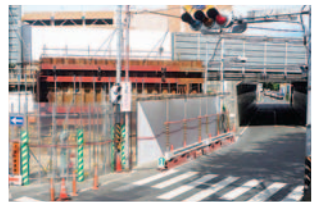
工事が進む東名下の歩行者用トンネル
