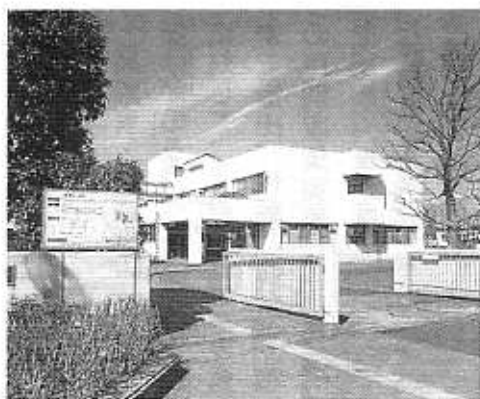
二ツ橋にある移転が決まった「横浜アレルギーセンター」
