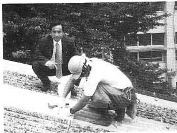
体育館の屋根の上のほり修復現場を見る(H.11 瀬谷第二小学校)
